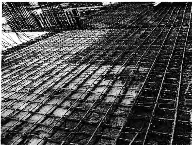
Gambar. Plat tulangan plat lantai yang sudah jadi Lokasi : komplek asrama haji medan
