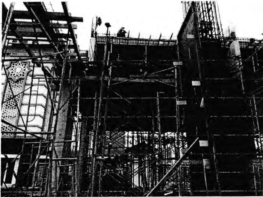
Gambar. Pemasangan Bakisting Kolom Lokasi : kompleks asrama haji medan
