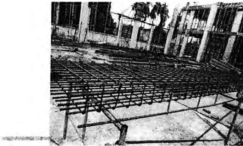
Gambar 3.5.8 Pekerjaan pemotongan dan pembungkakan tulangan
