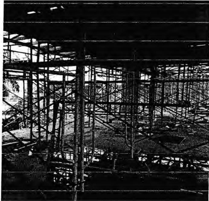
Gambar pemasangan scaffolding pada pengecoran plat lantai Lokasi : komplek asrama haji
