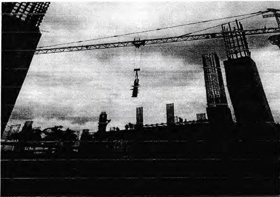
Gambar. Pengangkatan bekisting dengan tower crane Lokasi : kompleks asrama haji medan
