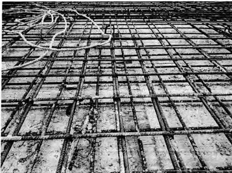
Gambar 3.5.8 Tulangan plat lantai
