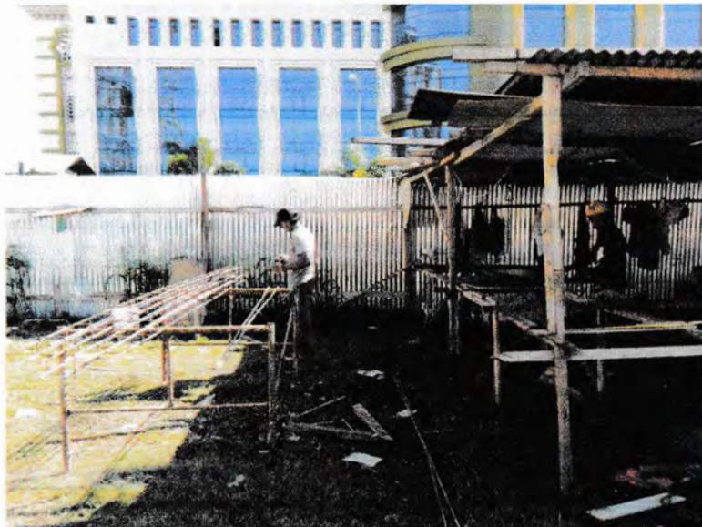
Gambar 2.3 Perakitan Besi Tulangan Kolom
