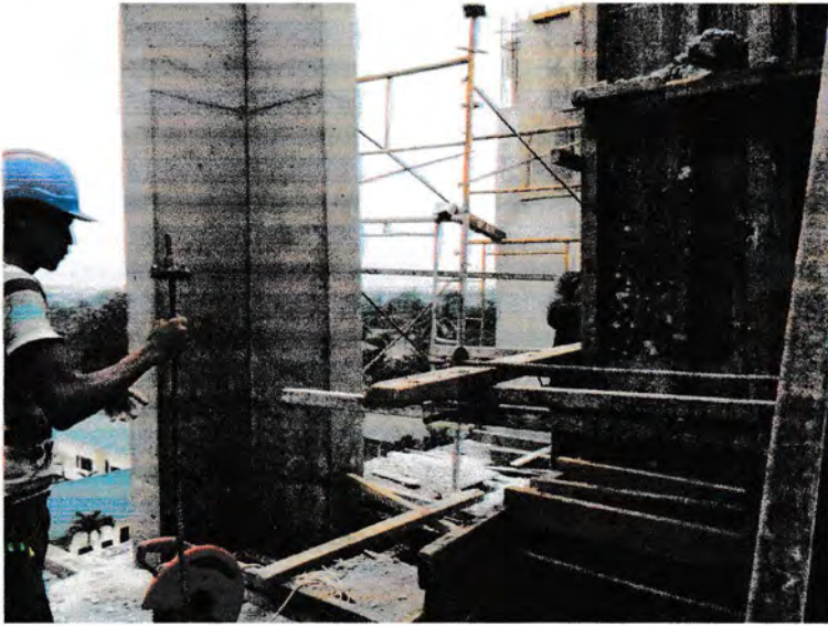
Gambar 4. Proses Pembukaan Bekisting Kolom
