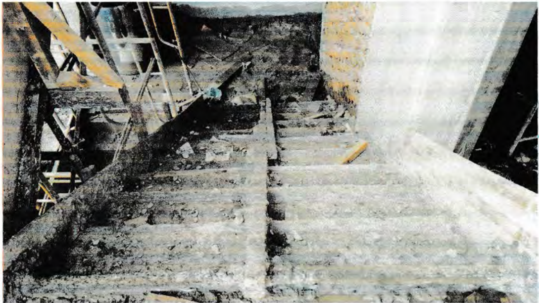
Gambar 6. Pemasangan Bekisting dan Pembesian Tangga
