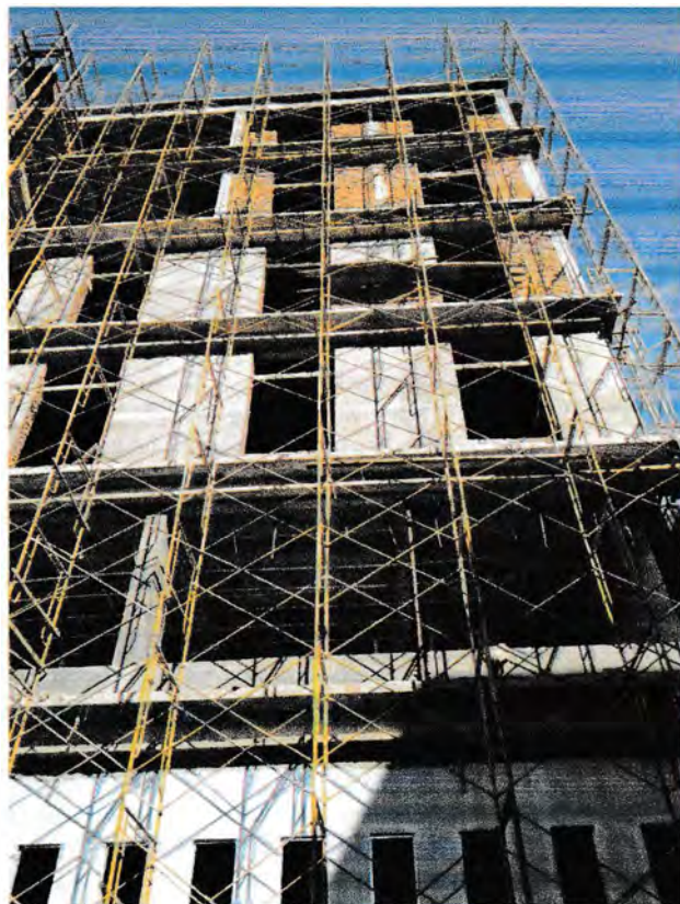
Gambar 1. Tampak Struktur Gedung
