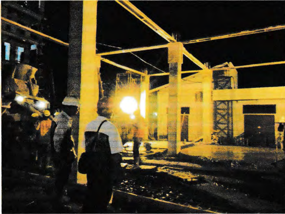
Gambar 7. Proses Pengecoran plat lantai
