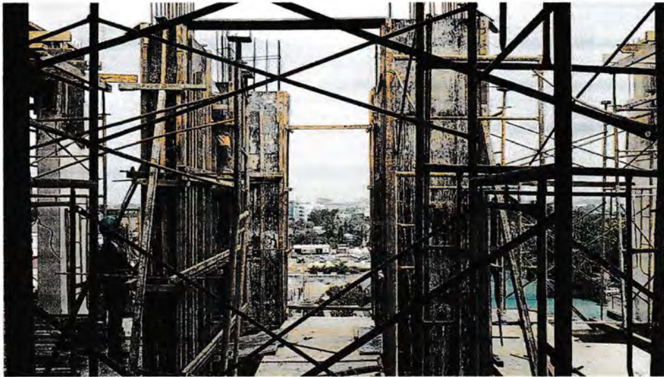
Gambar 3. Pemasangan Bekisting Kolom
