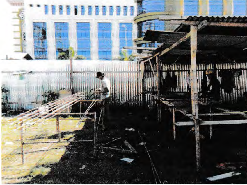
Gambar 2. Perakitan Besi Tulangan Kolom
