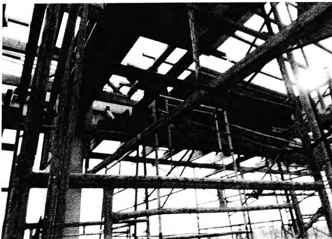
Gambar pemasangan scaffolding pada pengecoran plat lantai
