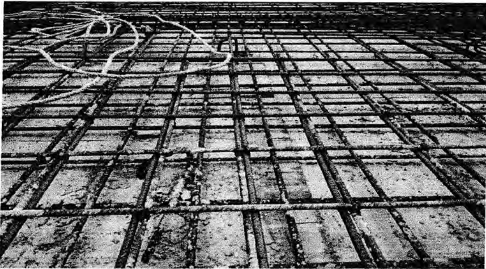
Gambar 3.5.8 Tulangan plat lantai
