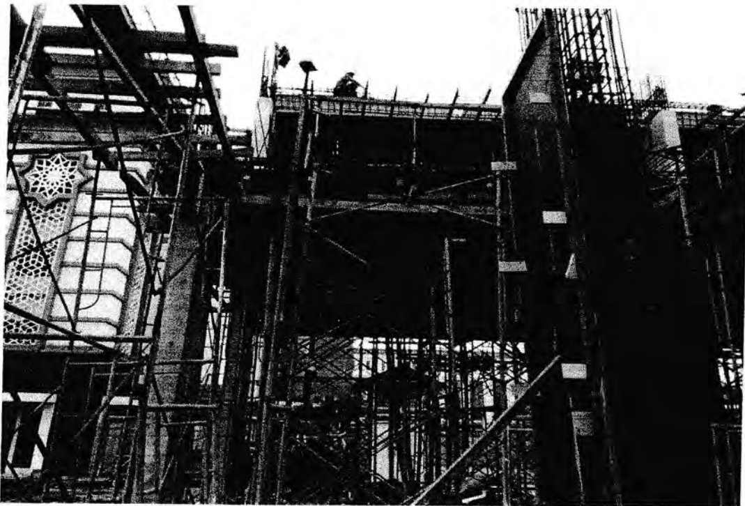
Gambar 3.12 Bekisting kolom
