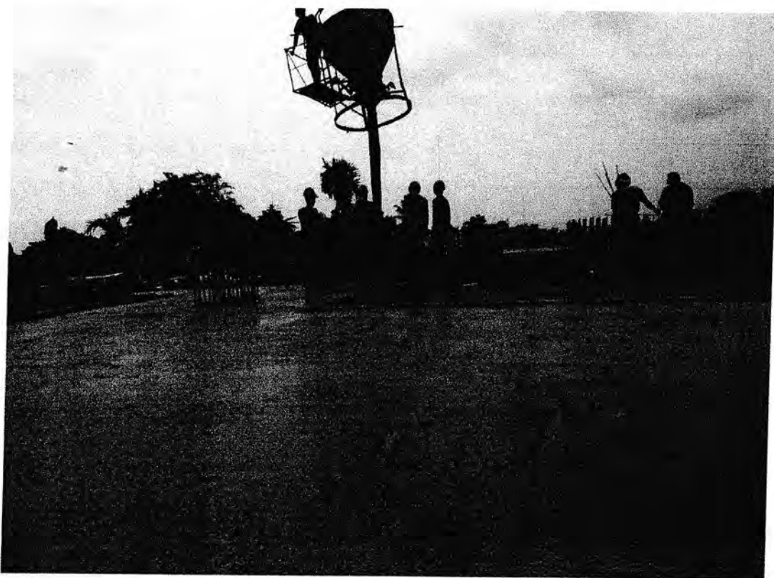
Gambar 3.11 Pengecoran Plat Lantai
