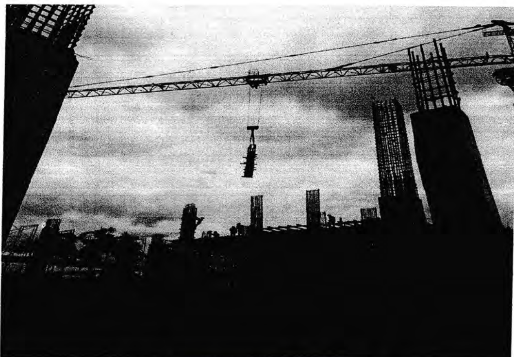
Gambar. Pengangkatan bekisting dengan tower crane
