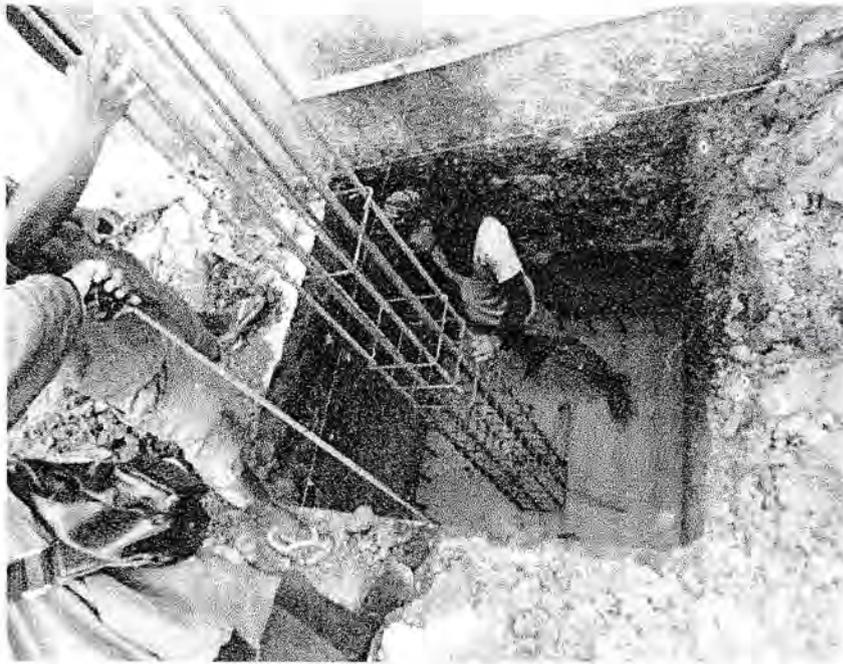
Gambar 1 : Pemasangan Tulangan Pile Cap
