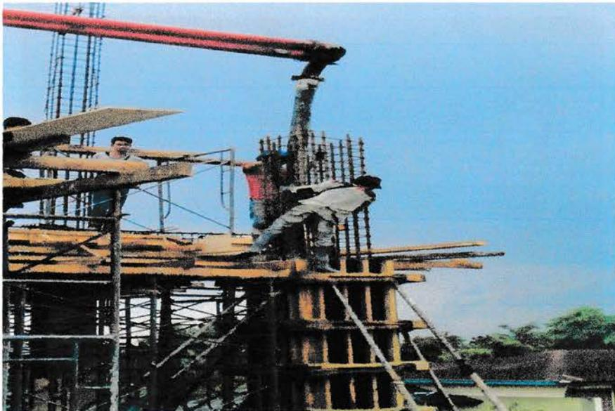
Gambar 8. Proses Pengecoran Kolom
