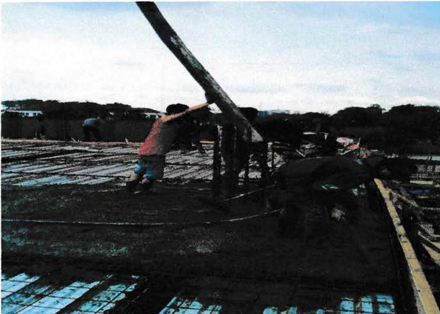
Gambar 12. Pengecoran Plat Lantai
