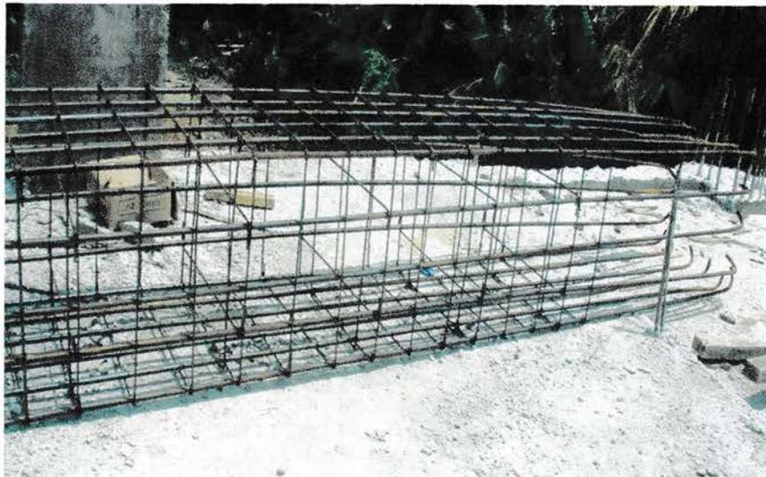
Gambar 4. Rangkaian Kolom
