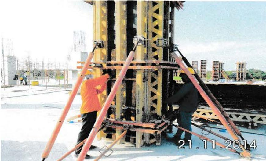
Gambar 6. Pemasangan Bakisting Kolom
