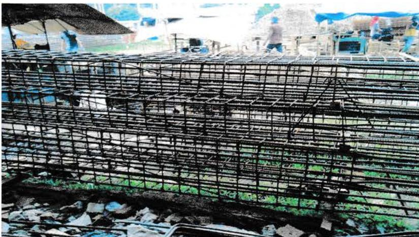
**Gambar 3.4. Pekerjaan pemotongan dan pembungkukan tulangan**
