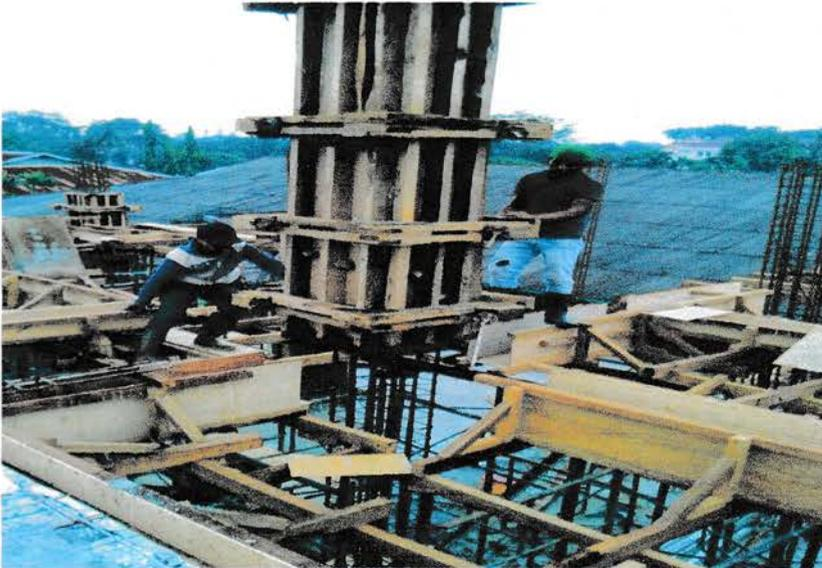
Gambar 9. Proses Pembukaan Bekisting Kolom dengan alat bantu *Tower Crane*
