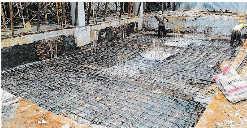
Gambar : Pekerjaan Plat Lantai
