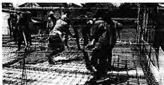
Gambar 3.15 Pengecoran Plat Lantai
