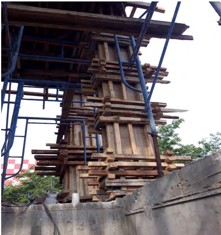
Gambar 1.11 Bekisting Kolom
