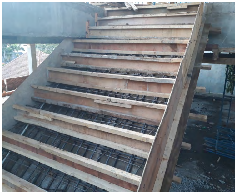
Gambar 3.16 Pemasangan Bekisting Tangga
