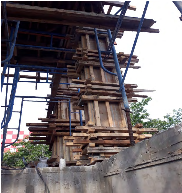
Gambar 1.11 Bekisting Kolom
