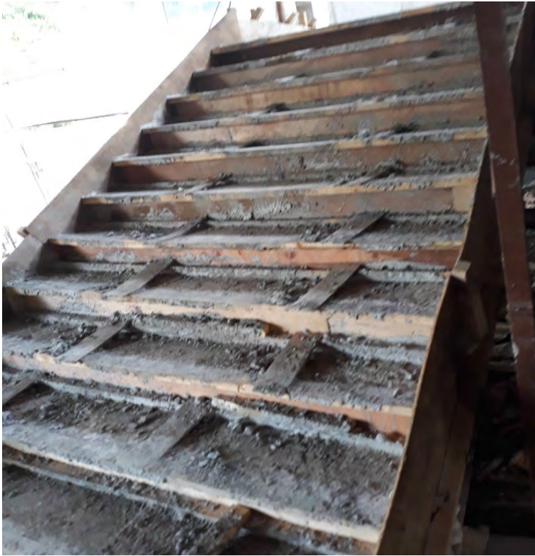
Gambar 1.12 Bekisting Tangga
