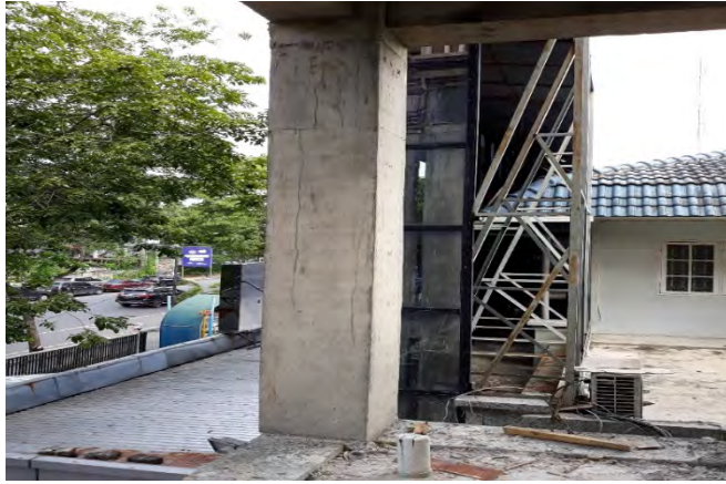
Gambar 1.18 Kolom yang sudah tercetak
