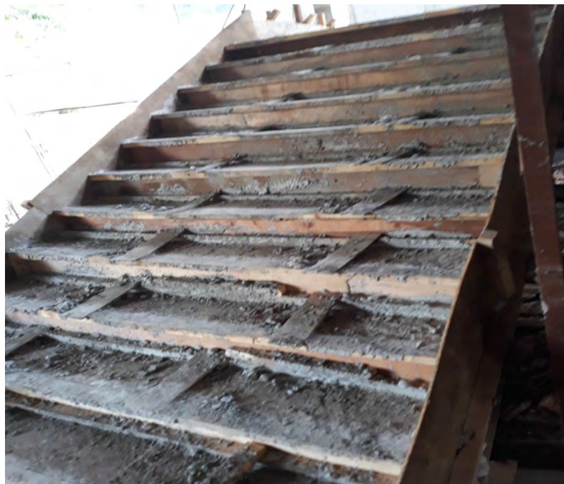
Gambar 3.21 Bekisting plat tangga
