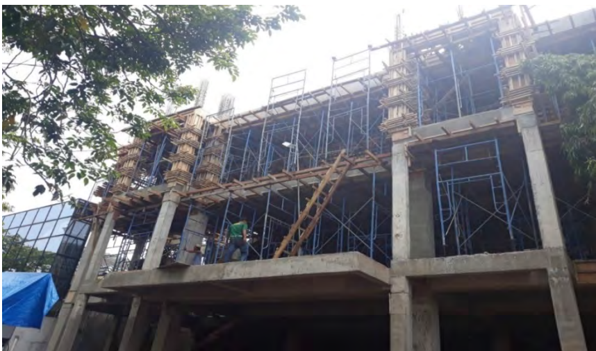
Gambar 1.20 Proses pengerjaan gedung bank BCA
