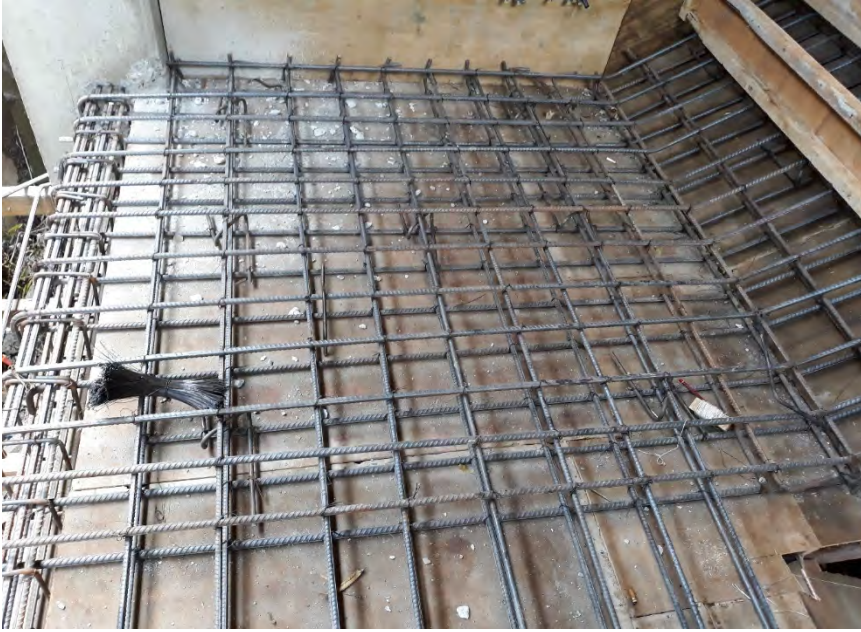
Gambar 1.10 Pembesian Plat Tangga
