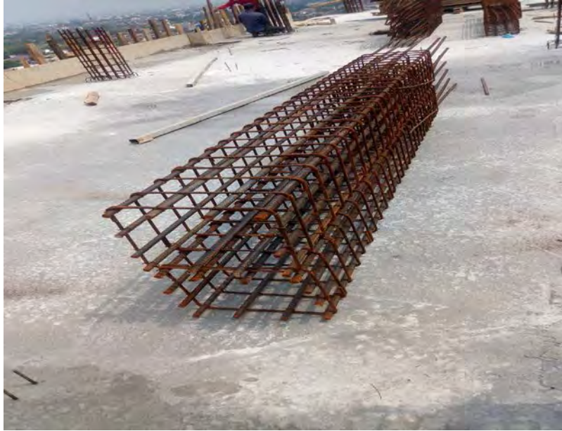
Gambar 3.22 Pekerjaan pemotongan dan pembengkokan tulangan
