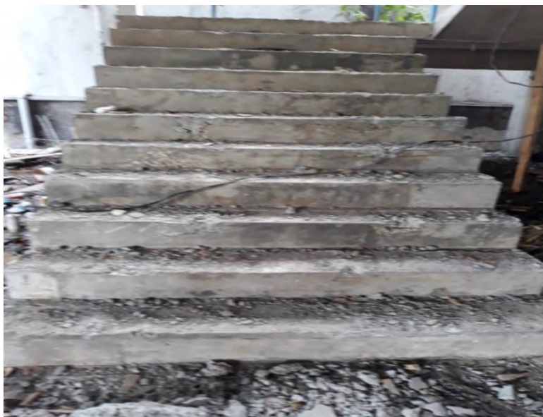
Gambar 1.17 Plat Tangga yg sudah tercetak
