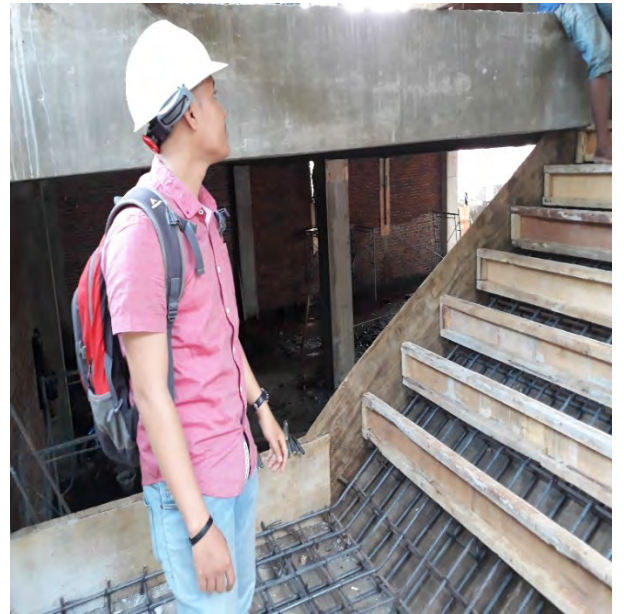
Gambar 1.2 penulangan Plat Tangga
