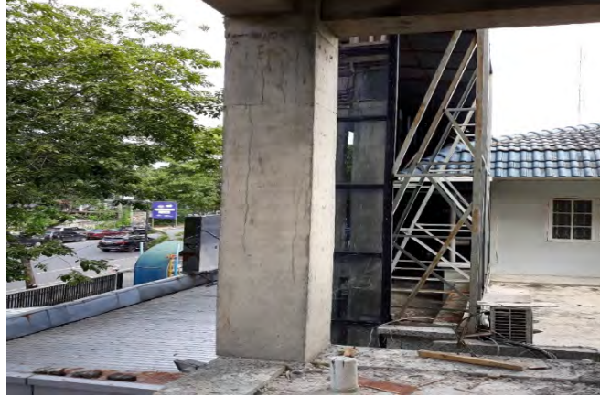
Gambar 1.18 Kolom yang sudah tercetak
