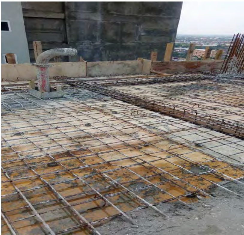
Gambar 1.9 Pembesian Plat Lantai
