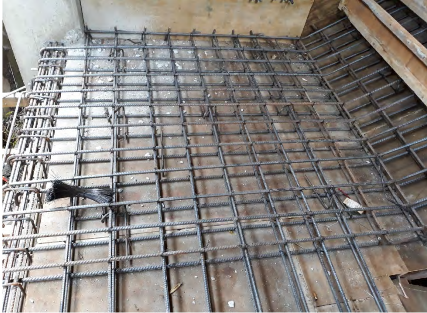
Gambar 1.10 Pembesian Plat Tangga
