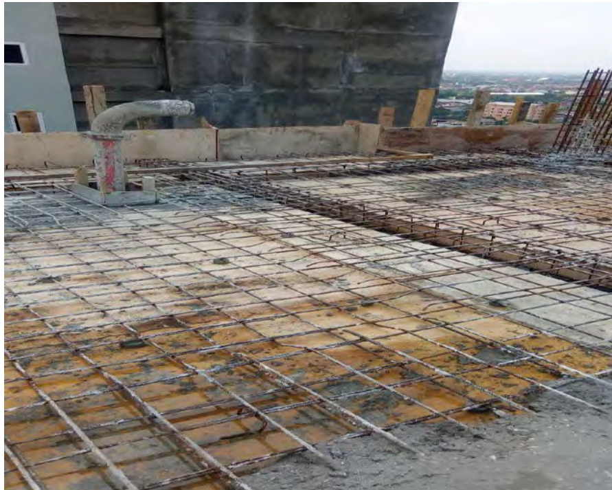
Gambar 3.25 Tulangan plat lantai
