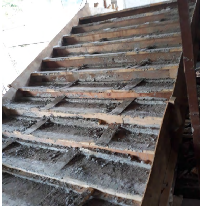
Gambar 1.12 Bekisting Tangga
