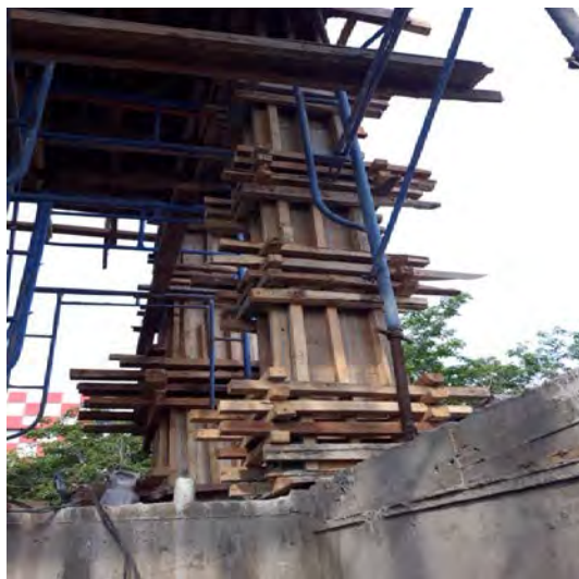
Gambar 3.18 Bekisting kolom
