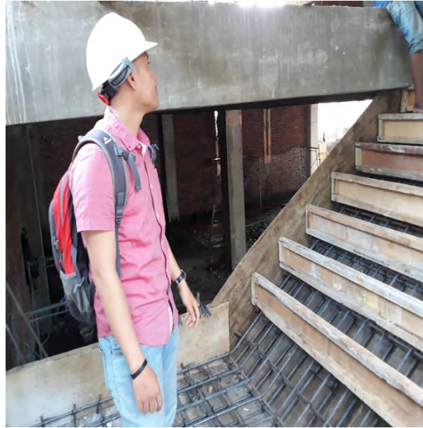
Gambar 1.2 penulangan Plat Tangga
