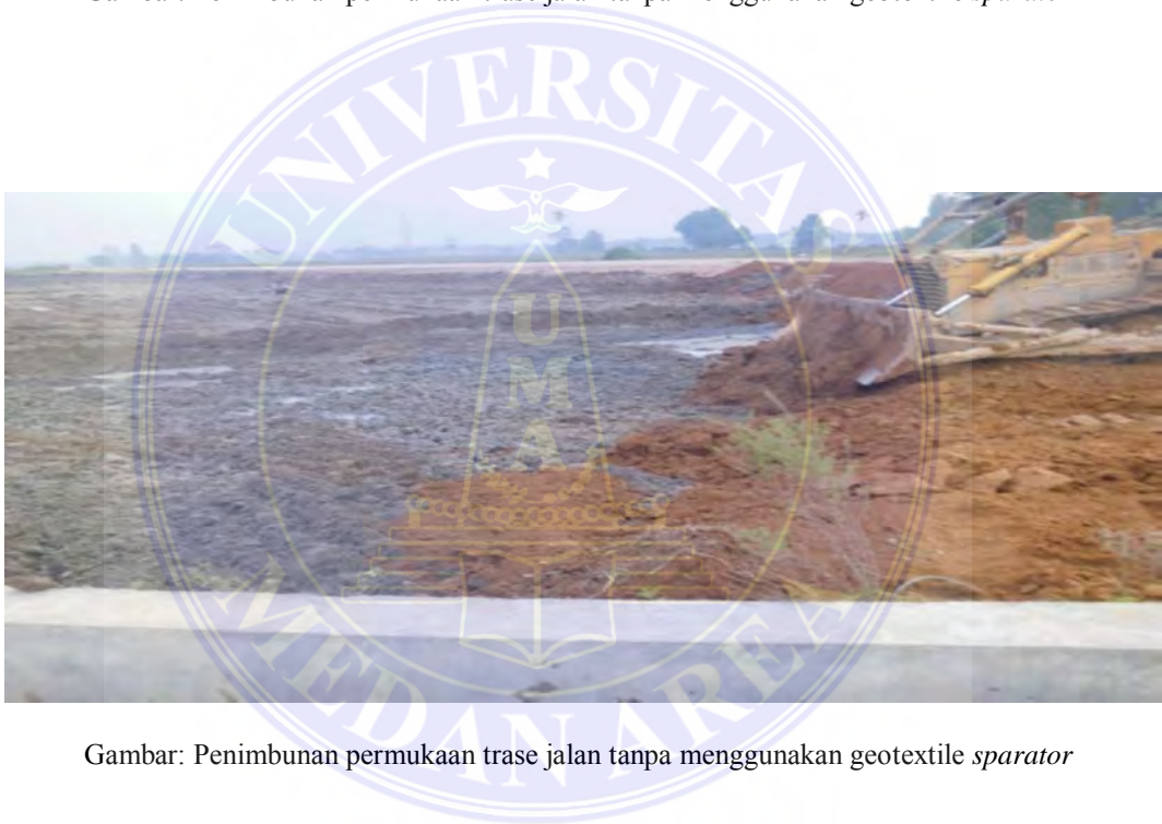
Gambar: Penimbunan permukaan trase jalan tanpa menggunakan geotextile sparator
