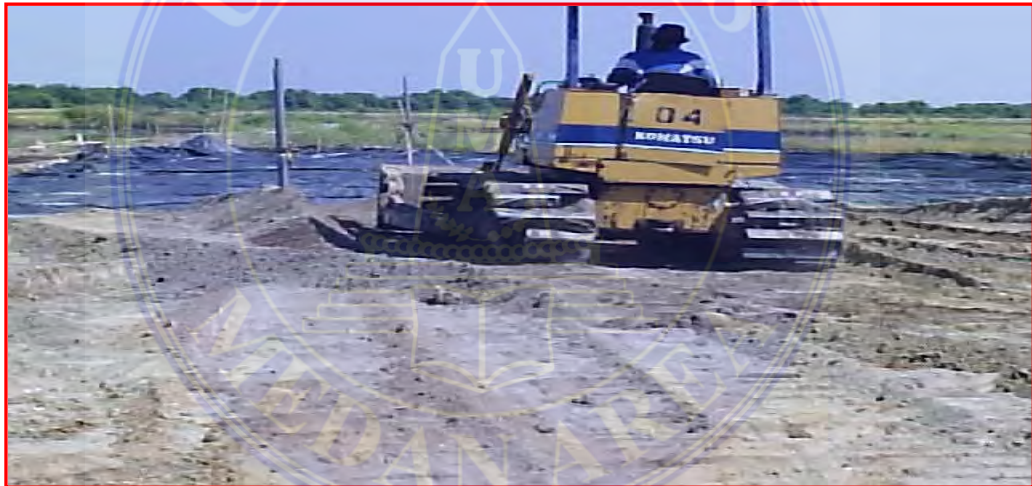
Gambar: Penghamparan material pada permukaan trase jalan yang diberi geotextile sparator
