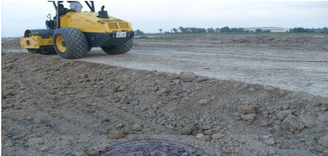
Gambar: Hasil Pematatan pada permukaan trase jalan diberi yang geotextile sparator
