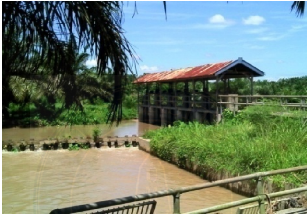
Gambar 3.2 Kondisi Intake D.I. Perkotaan
