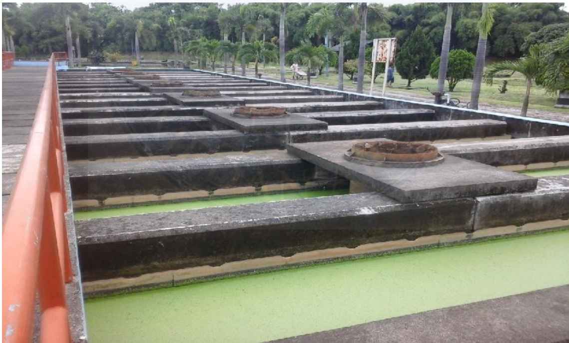
Gambar 6 : Bak pengolahan dengan cara memasukan udara ke dalam air limbah
