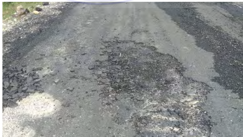
Gambar 41. Pengelupasan lapisan permukaan (Serambi 2008)
