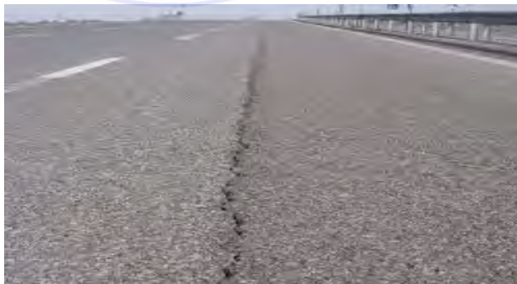
Gambar 30. Retak sambungan pelebaran jalan, (Shahin 2003)
