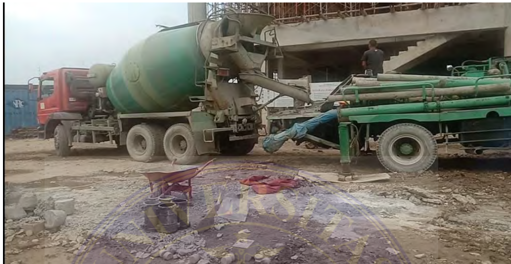
Gambar 1 : Persiapan Truk Molen Besar Untuk Melakukan Pengecoran
