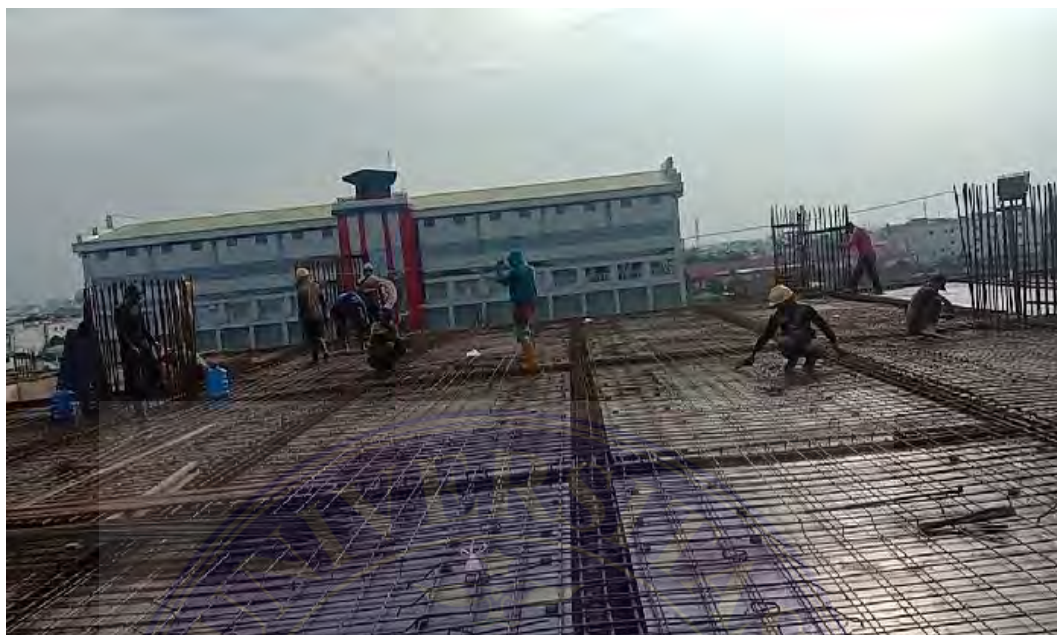
Gambar 3 : Pemasangan Tahu Beton Pada Rangka Plat Lantai 4
