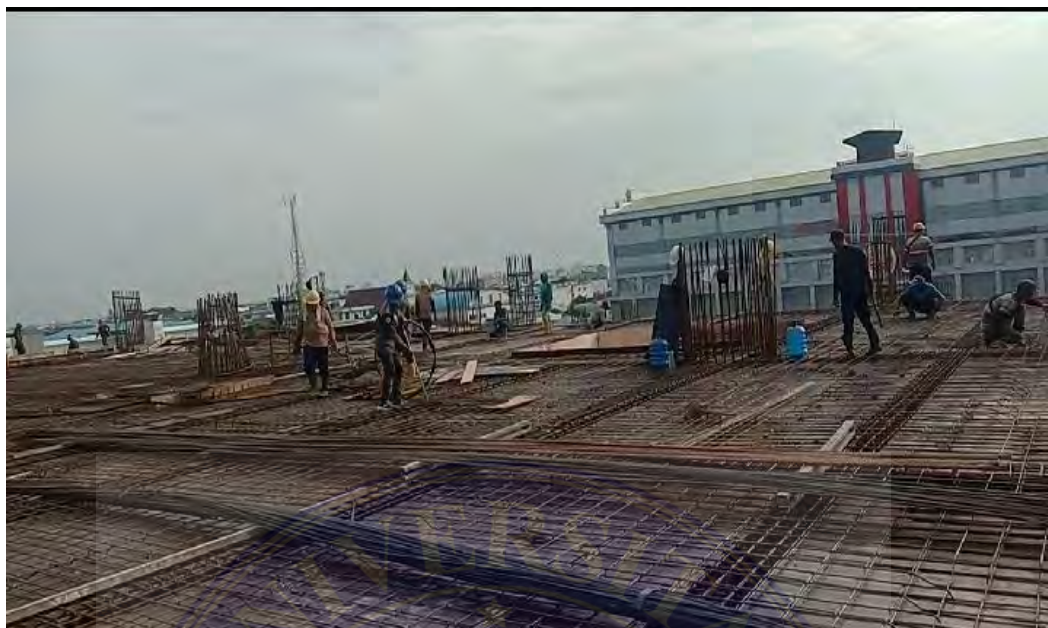
Gambar 5 : Pembersihan Ruang Balok Menggunakan Vibrator
