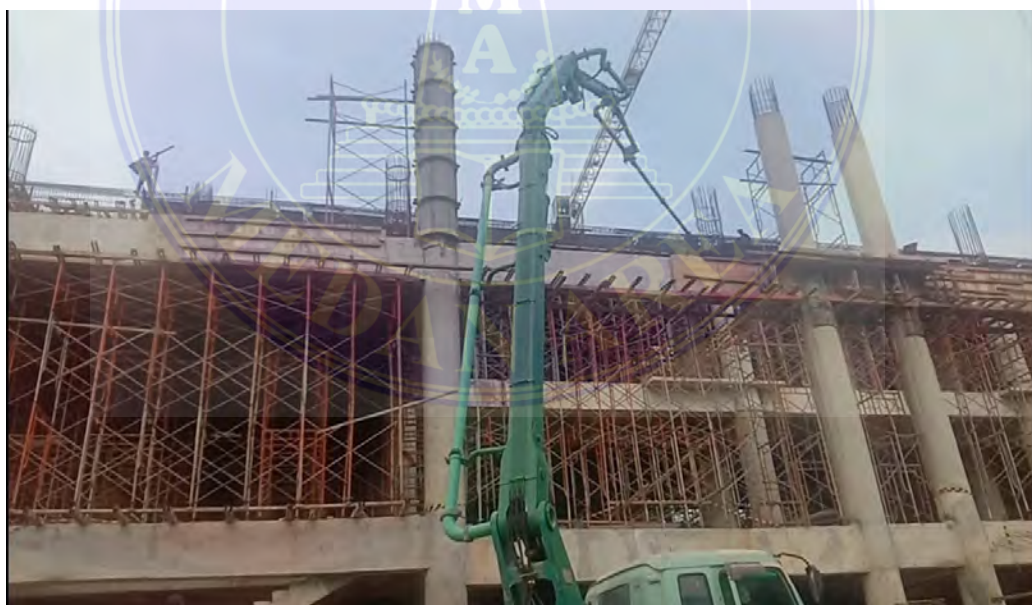
Gambar 2 : Pengecoran Beton Pada Plat Lantai 3
