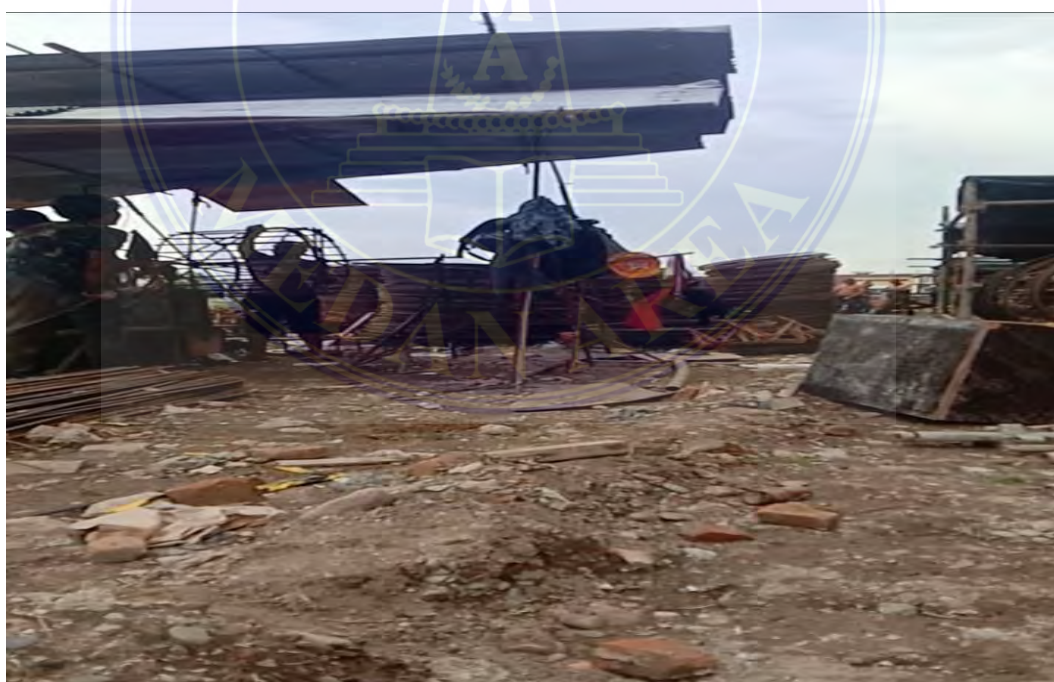
Gambar 10 : Proses Pembuatan Cincin Silinder Tulangan Kolom
