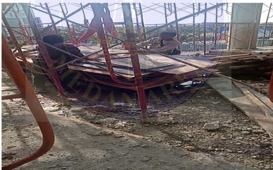
Gambar 8 : Pemasangan Ikatan Tali Tower Crane Sebelum Dipindahkan
