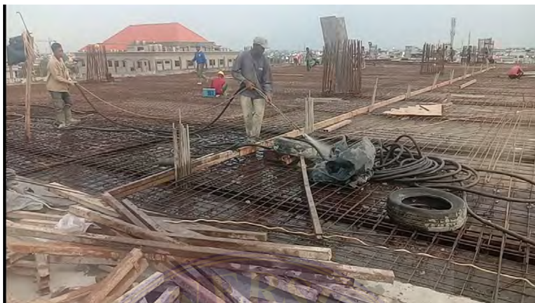
Gambar 7 : Penyemprotan Air Pada Rangka Plat Lantai Sebelum Pengecoran
