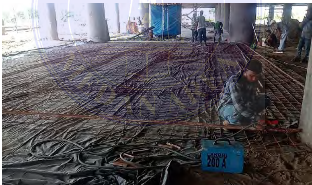
Gambar 6 : Pengelasan Tulangan Plat Lantai Agar Lebih Kuat
