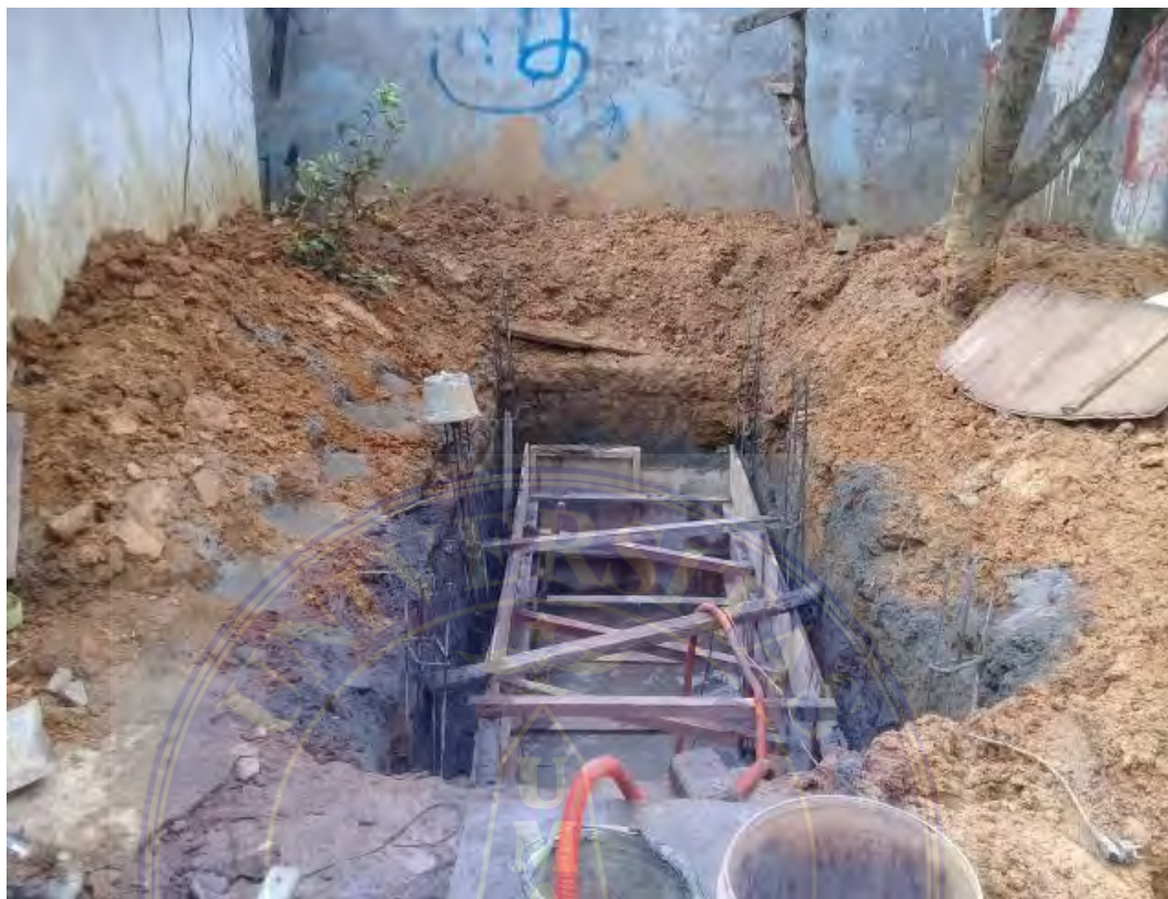
Gambar : Bekisting IPAL (dokumentasi penulis,2023)
