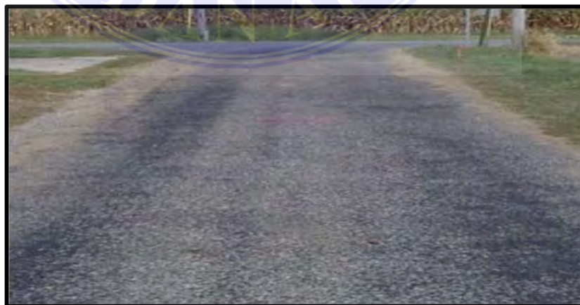
Gambar 21. Kegemukan ( bleeding/flushing ) ( https://dpu.kulonprogokab.go.id )
