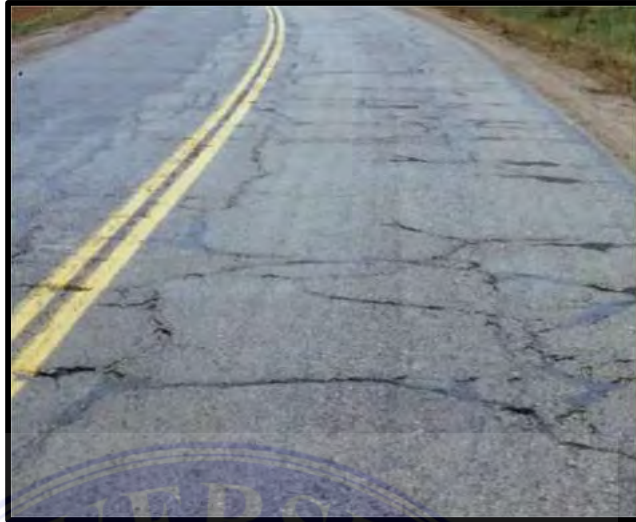
Gambar 8. Retak Refleksi ( https://dpu.kulonprogokab.go.id )
