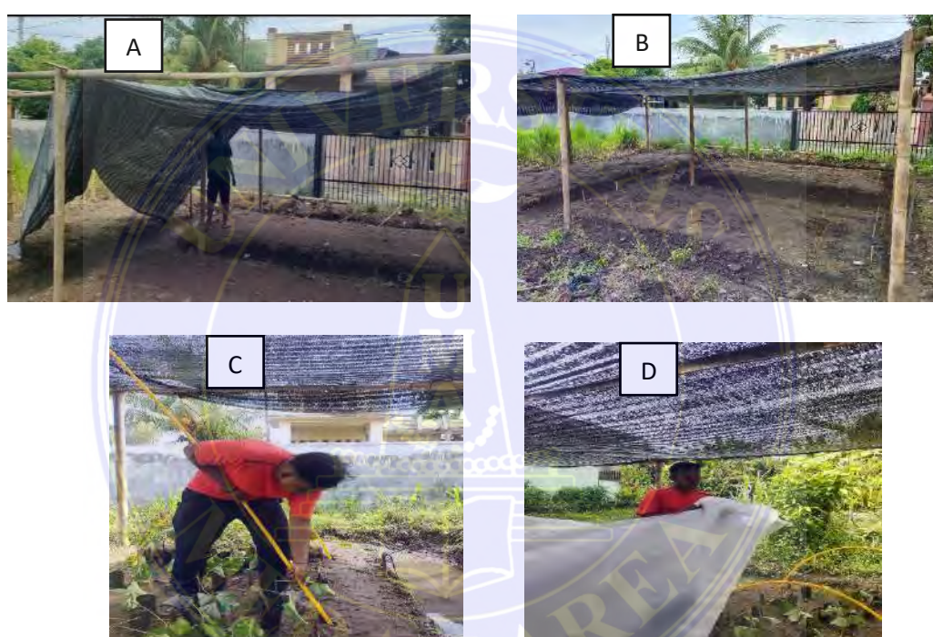
Gambar 2. A). Pemasangan Paranet, B). Tampak depan paranet sebagai naungan, C). Pemasangan penyangga sungkup, D). Pemasangan Sungkup tempat budidaya stek Mucuna bracteta . (Sumber; Dokumentasi pribadi, 2022)
