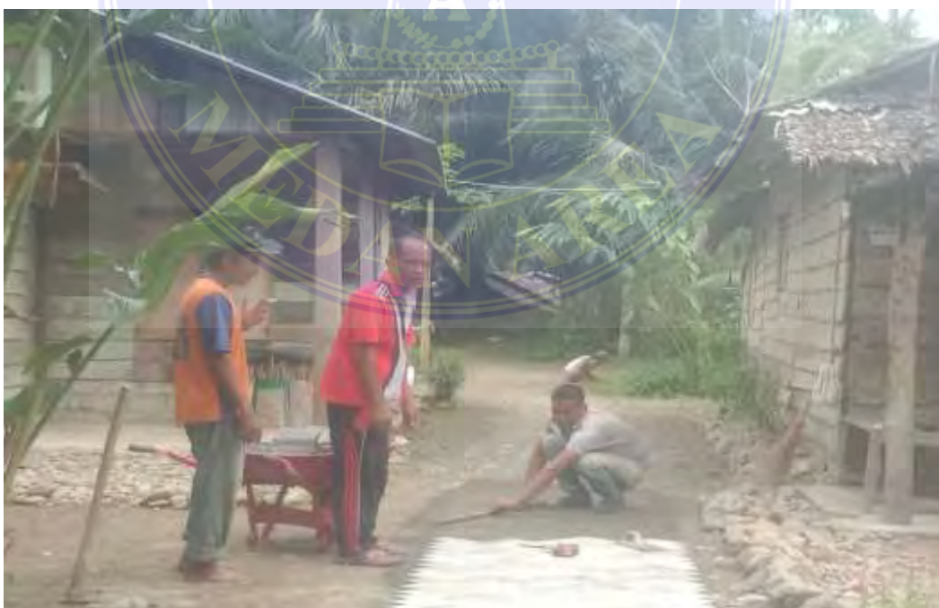
Pembangunan Jalan Dusun
