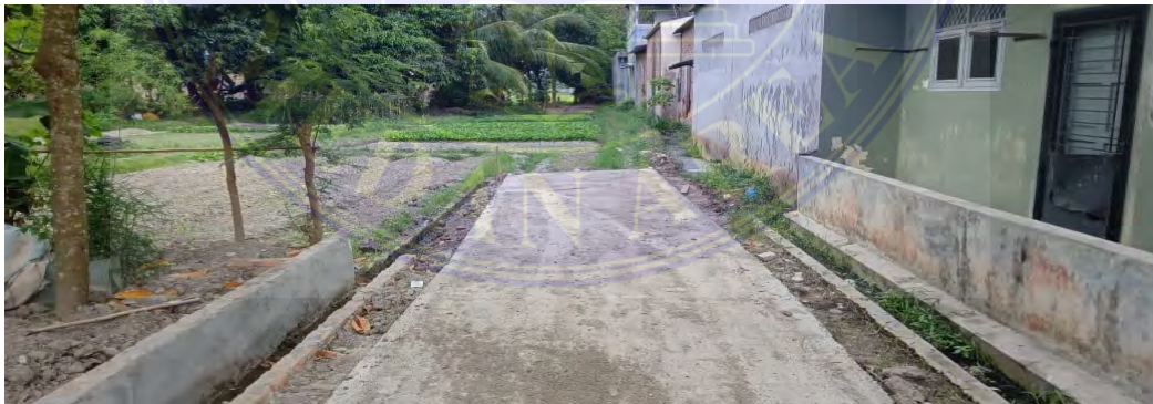
Dokumentasi masih selesai pembangunan jalan
