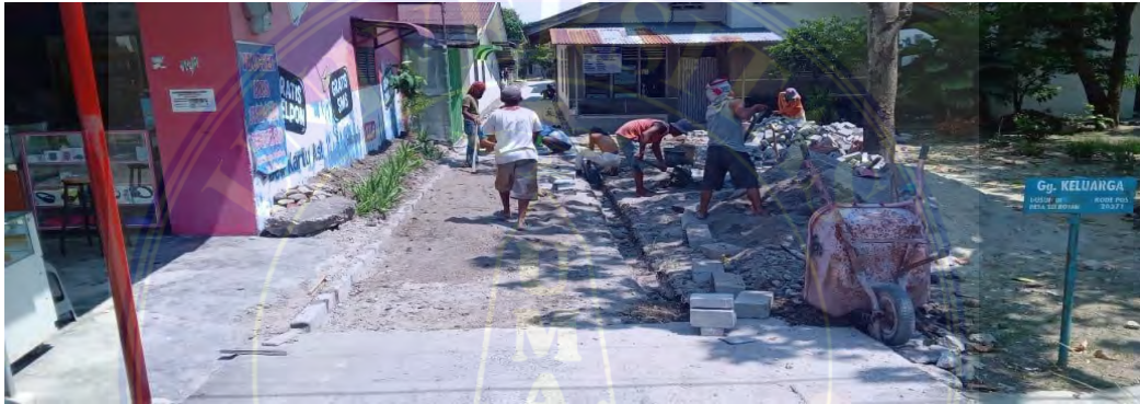
Dokumentasi gambar dalam pembangunan jalan di Desa Percut Sei Tuan
