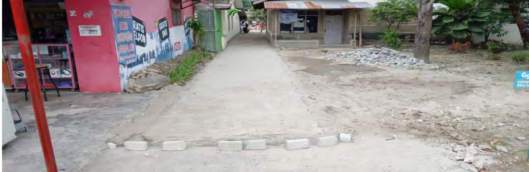
Dokumentasi setelah selesai pembangunan jalan
