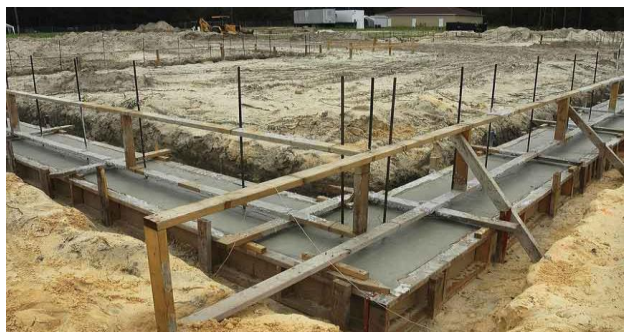
Gambar 2. Pondasi memanjang (Rahmatika, 2022)
