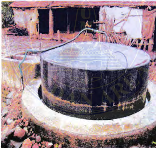
Gambar 2.4. Model unit gas bio sebagian tangki pencerna dibawah permukaan tanah.
