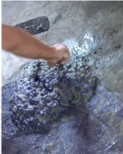
Gambar 3. 11. Pencampuran Agregat Beton
