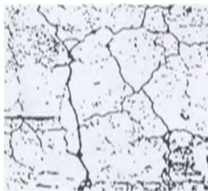
Gambar 2. 8. Retak akibat reaksi alkali– agregat
