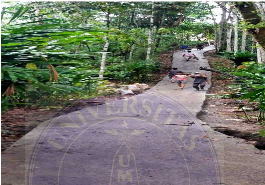
Gambar 7. Pembangunan Jalan Menuju Air Bersih (Sumber: Dokumentasi Pribadi, 2023)
