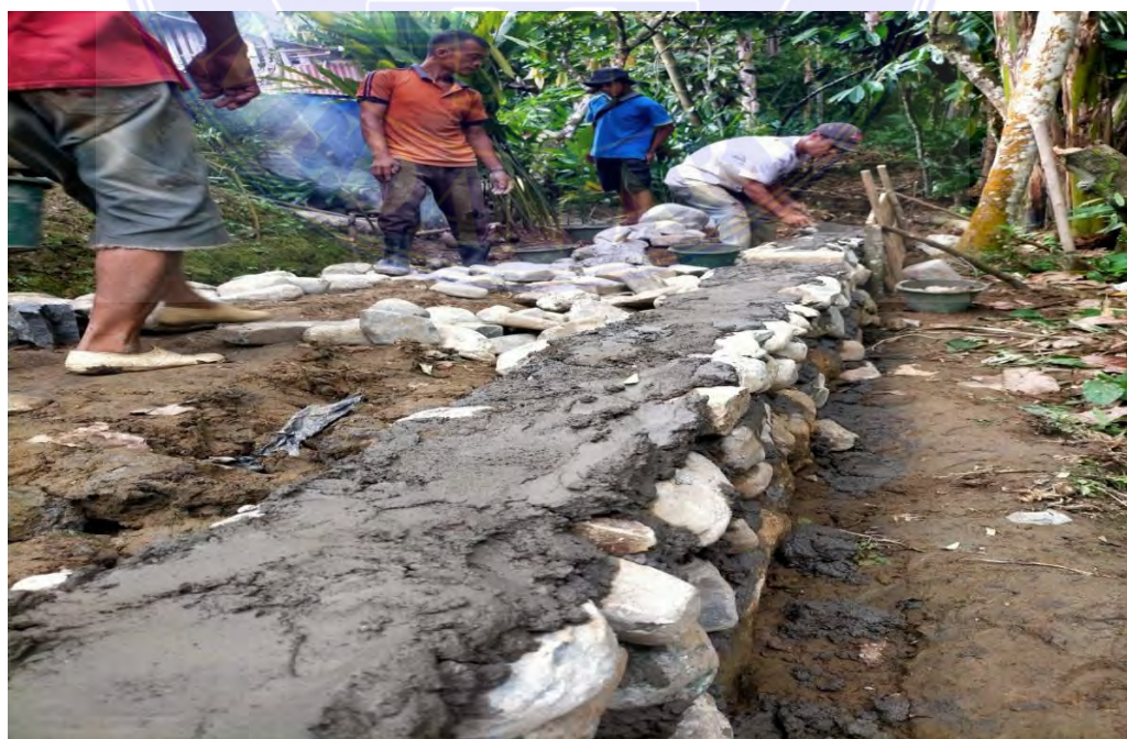
Gambar 8. Pembangunan Jalan Menuju Air Bersih
