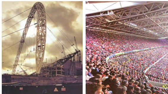
Gambar. 30 Tampak Struktur Kabel, dan struktur Atap Stadion Sumber : Seard rod The Stadium Architecture global culture
