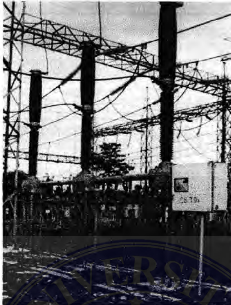
Gambar 2.2. PMT dengan media gas SF6
