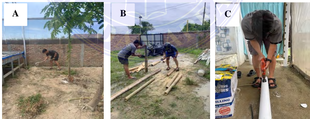
Gambar 2. Perisapan Areal A). Pembersihan Lahan, B)Pembuatan Dudukan Paralon, B) Persiapan Pipa Paralon
