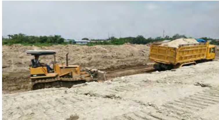
Dump Truck memasuki lokasi proyek
