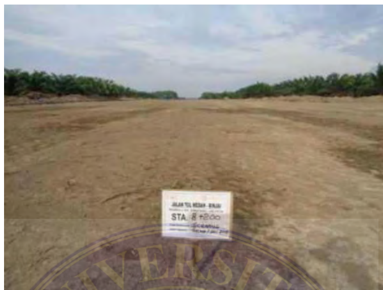
Hasil dari pekerjaan Borrow Material
