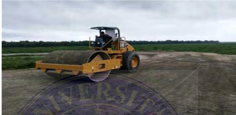
Sumber: Survei Lapangan Gambar 2.7: Vibratory Roller
