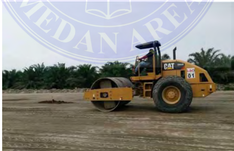
Pemadatan dengan alat Vibratory Roller
