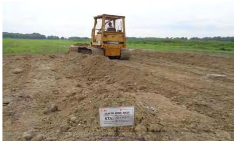
Penghamparan material timbunan dengan alat Buldozer
