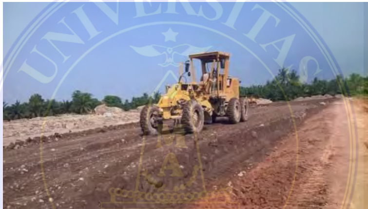
Perataan untuk kemiringan timbunan
