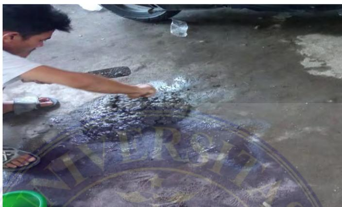
Gambar 3. 9. Pengadukan campuran agregat beton
