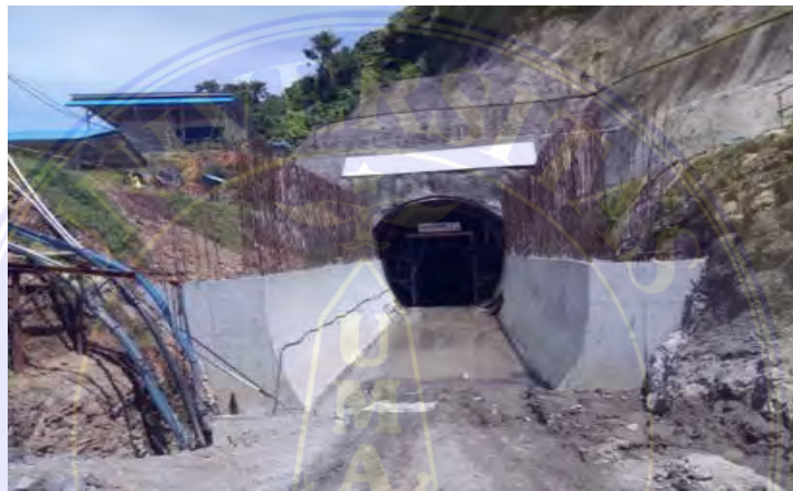
Gambar 3.2 Kondisi Terowongan Pengelak Bendungan Lau Simeme Sumber: PP-ANDESMONT KSO
