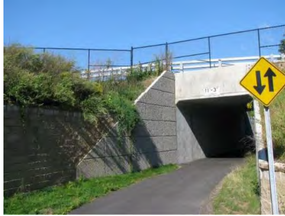
Gambar 2.7 Bentuk Terowongan Persegi Sumber: Wally, 2014
