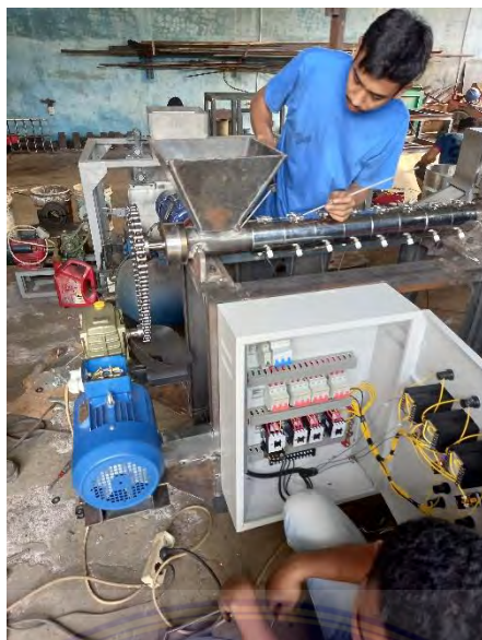
Gambar 4.7 Finishing pemasangan panel sistem kendali dan hopper
