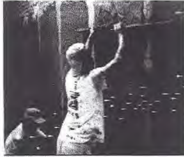
Gambar 4. Proses pekerjaan plsteran dinding No.10
