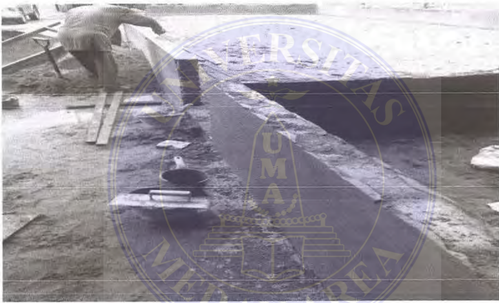
Gambar 7 :proses pekerjaan plesteran
