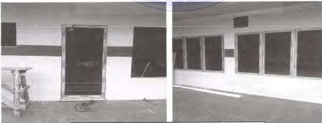
Gambar 16 : proses pekerjaan pintu dan jendela
