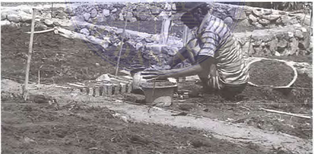
Gambar 3 :proses pemasangan pondasi
