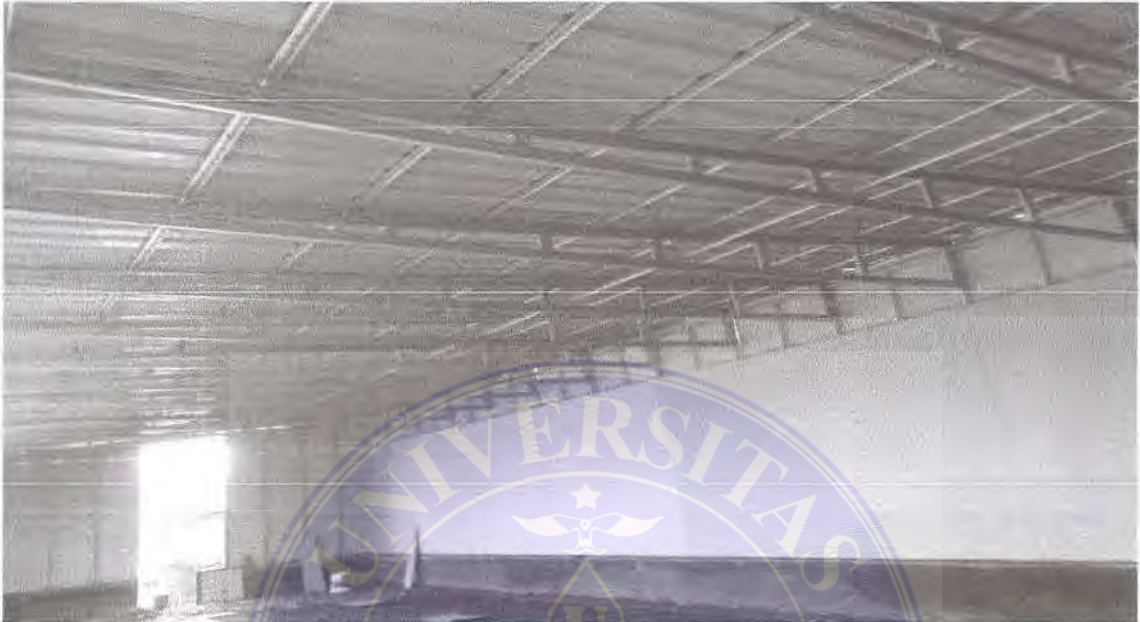
Gambar 10 :pemasangan kuda kuda
