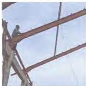
Gambar 3. 13 Pemasangan gording
