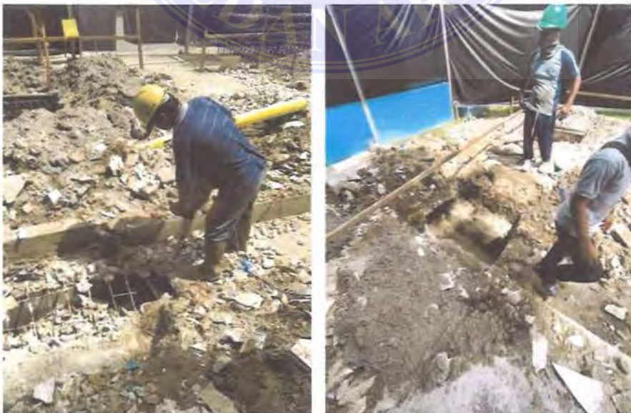
Gambar 6. Proses pembongkaran bis beton dan drainase lama
