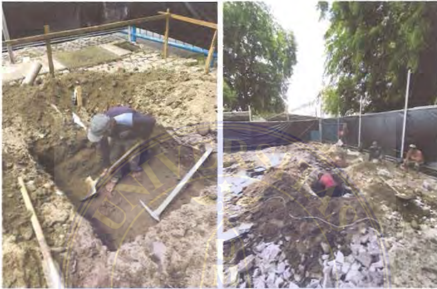
Gambar 5. Proses penggalian tanah pondasi
