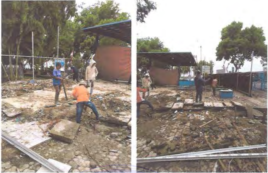
Gambar 7. Proses pembongkaran lantai keramik lama dan paving block
