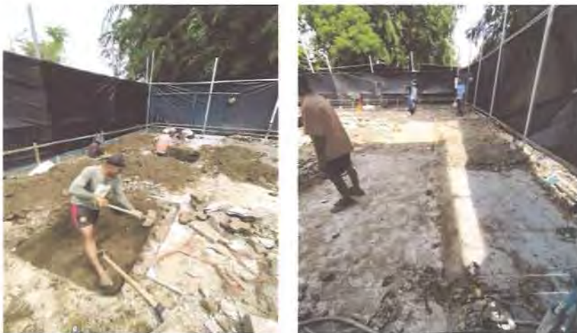
Gambar 4. Proses penggalian tanah pondasi dan penentuan titik galian pondasi
