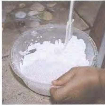
Gambar 3. 2 Pencampuran Gypsum dan Air
