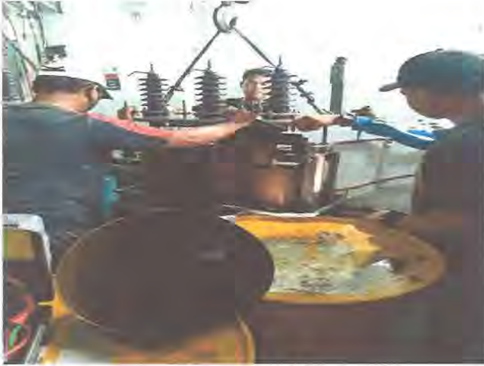
Gambar 3.19 Proses memasukkan Trafo ke Bak (badan) Trafo
