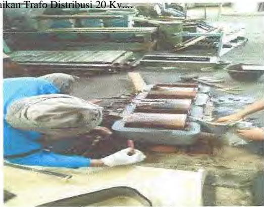
Gambar 3.12 Proses pemasangan Kern (Inti Besi) Trafo
