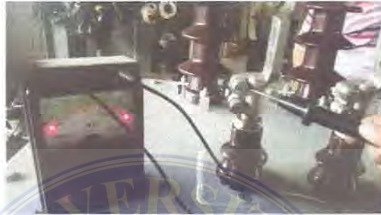
Gambar 3.4 pengecekan Trafo menggunakan Megger
