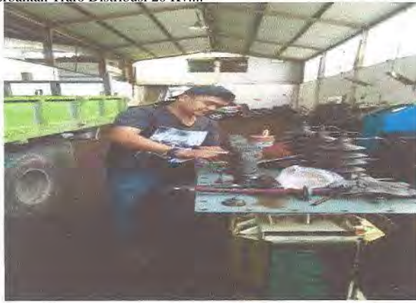
Gambar 3.14 Proses mengganti Bushing yang rusak
