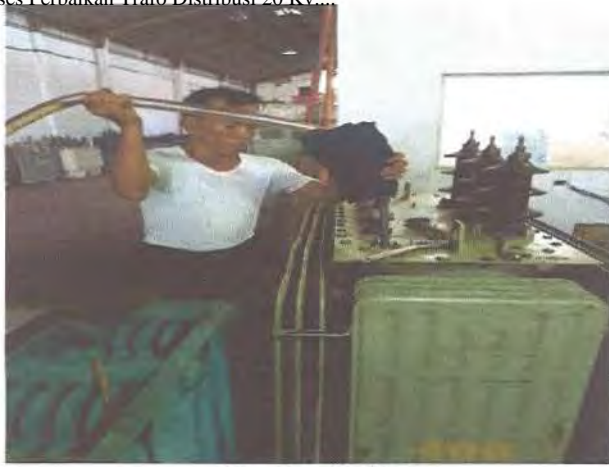
Gambar 3.22 Proses pengisian minyak trafo
