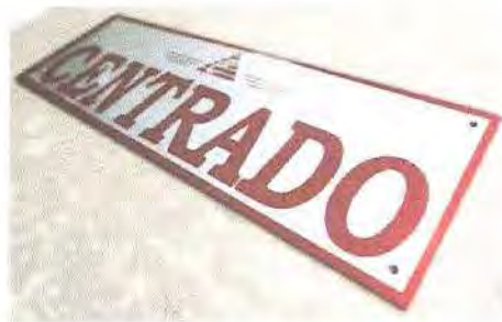
Gambar 2.11 Brand Marking pada trafo
