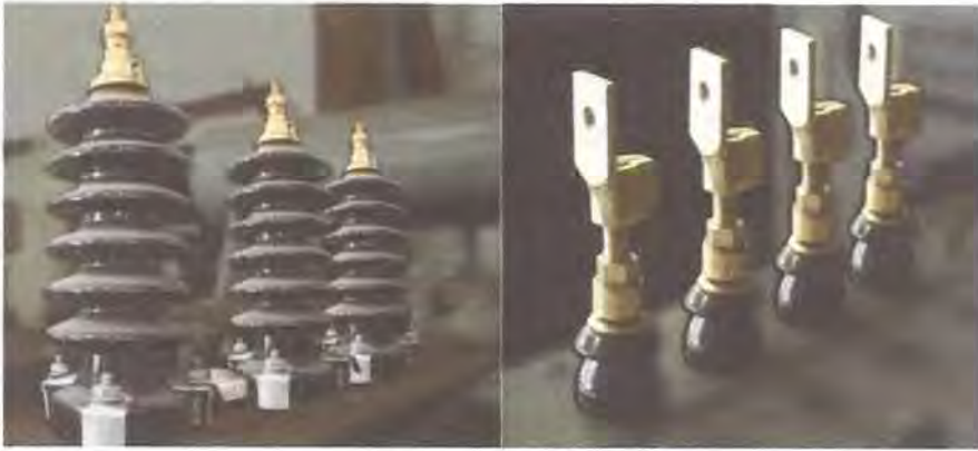
Gambar 2.6 Bushing pada transformator
