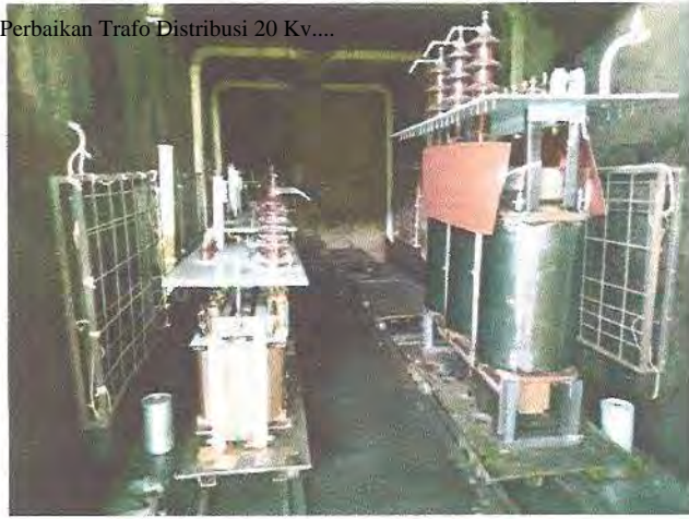
Gambar 3.16 Proses pengovenan Trafo
