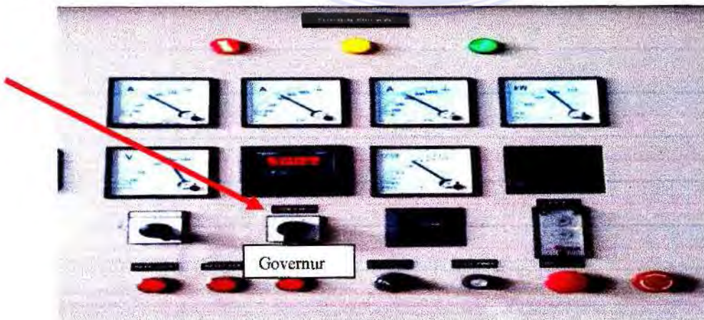
Gambar 14: Proses Sinkron (Governur) (Sumber: Penulis, 2020)
