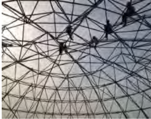
Gambar 5.22. Rangka Atap Space Frame
