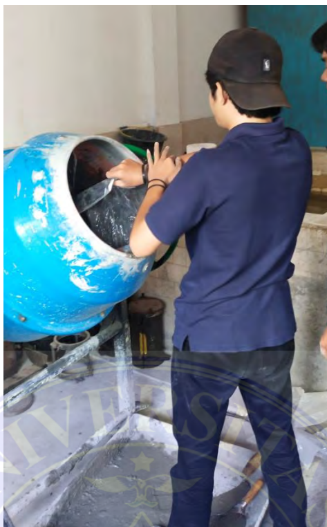
Pencampuran beton Sumber : Dokumentasi, 2022
