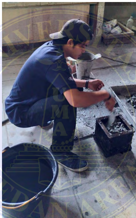
Memasukkan campuran beton kedalam cetakan kubus
