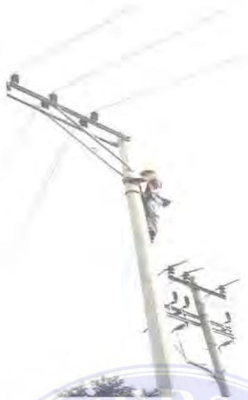
Gambar 2.4 (3) Kontruksi SUTM 3 Fasa Single Circuit
