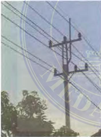
**Gambar 2.4 (2) Konstruksi SUTM 1 Fasa – 3 Fasa**
