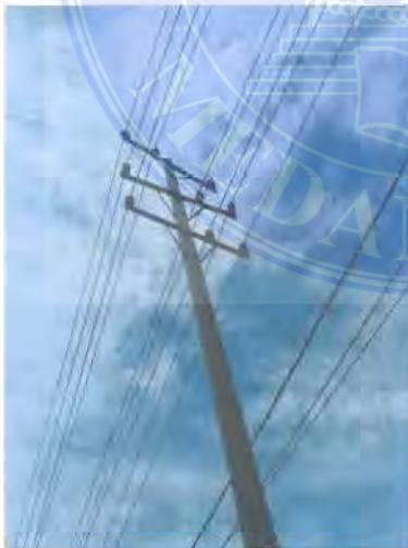
Gambar 2.4 (4) Konstruksi SUTM 3 Fasa Singe Circuit
