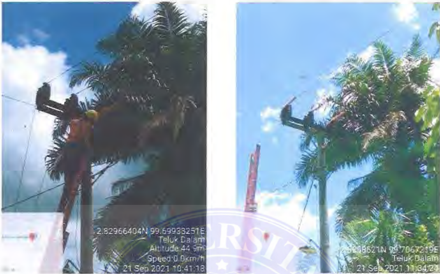
a. Proses Pemasangan Isolasi pipa paralon b. Jaringan terisolasi dari pipa paralon
