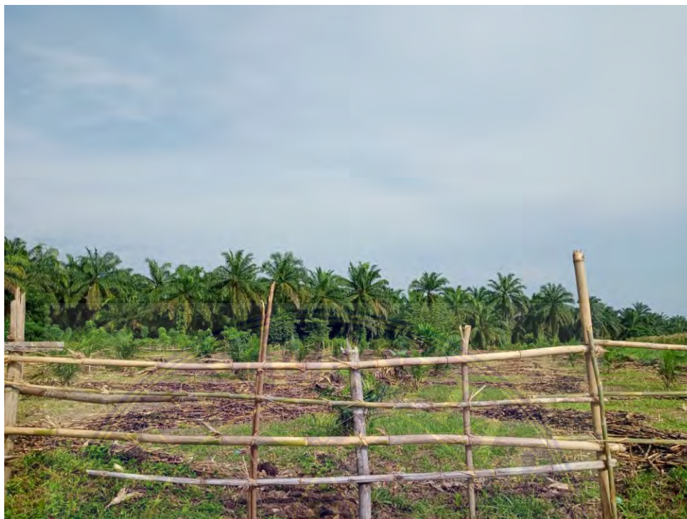
Pembersihan Areal Lahan Kelapa Sawit TBM
