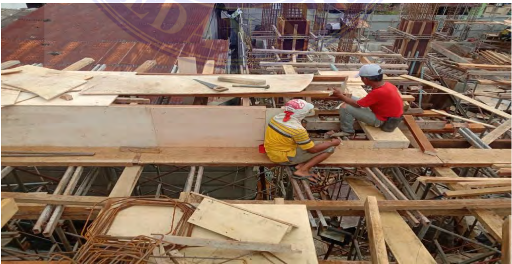
Gambar 4.5 Pemasangan bekisting Sumber Data : Lapangan
