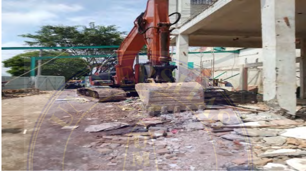
Gambar 3.14 Excavator Sumber Data : Lapangan
