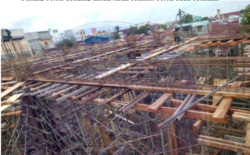
Gambar 4.1 Pemasangan Tulangan Sumber Data : Lapangan
