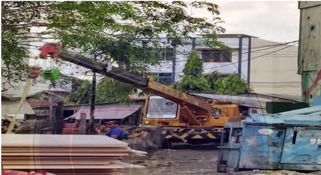
Gambar 3.12 Truck Crane Sumber Data : Lapangan
