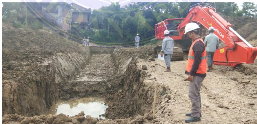
Gambar 2. Penggalian Lantai kerja.
