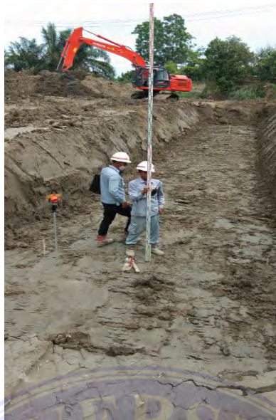
Gambar 3. Pengukuran Lantai kerja.
