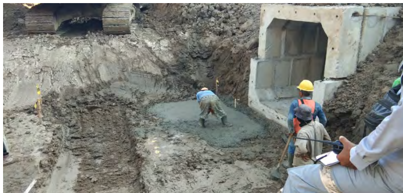
Gambar 8. Pengecoran lantai kerja Outlet & Inlet.
