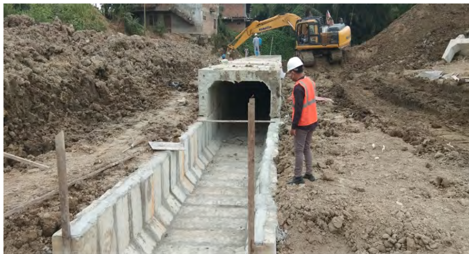
Gambar 6. Penyusunan Box Culvert Atas.
