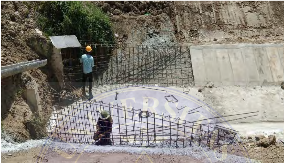
Gambar 3.17 Saluran Transisi.
