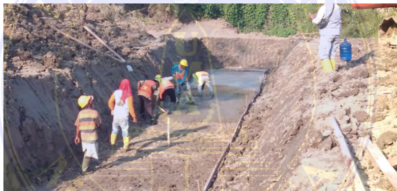
Gambar 4. Pengecoran Lantai kerja.
