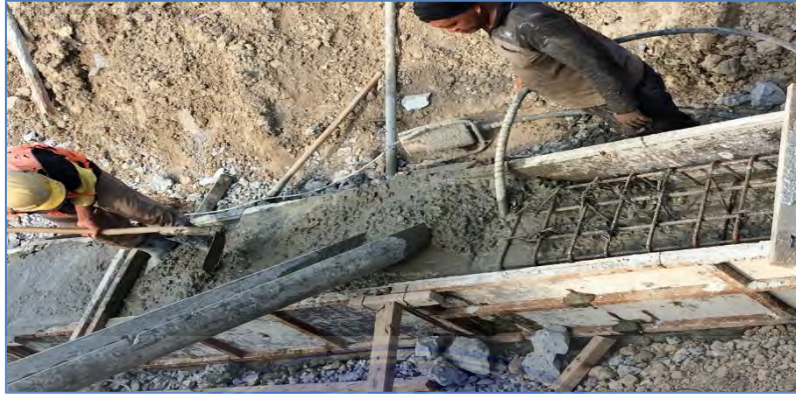
Gambar 3.21 Pematatan Beton Dengan Vibrator
