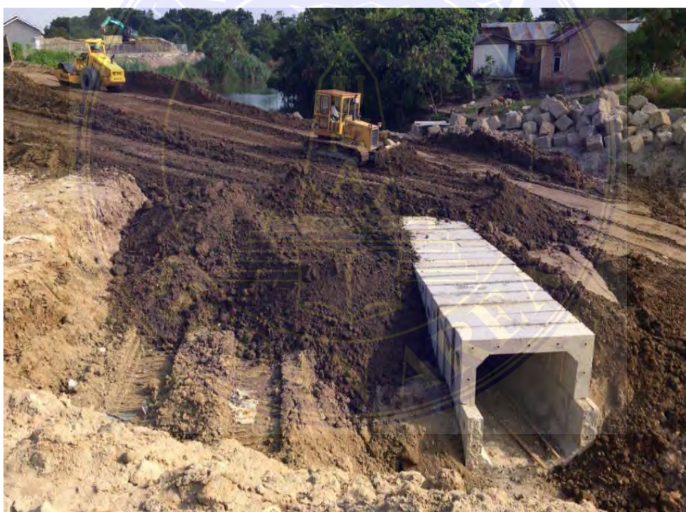
Gambar 6. Penyusunan Box Culvert Atas.
