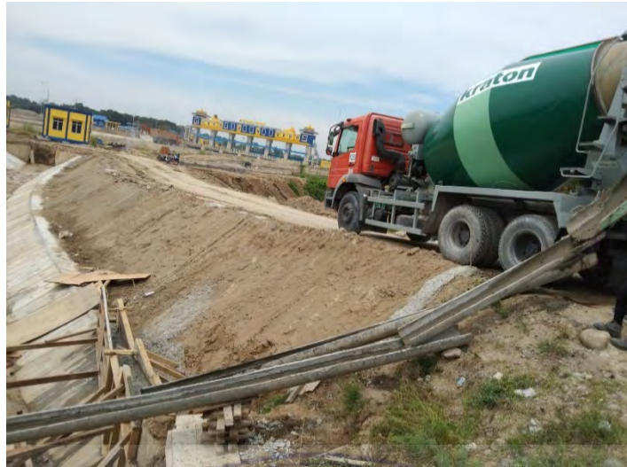
Gambar 3.15 Pekerjaan Pengecoran.
