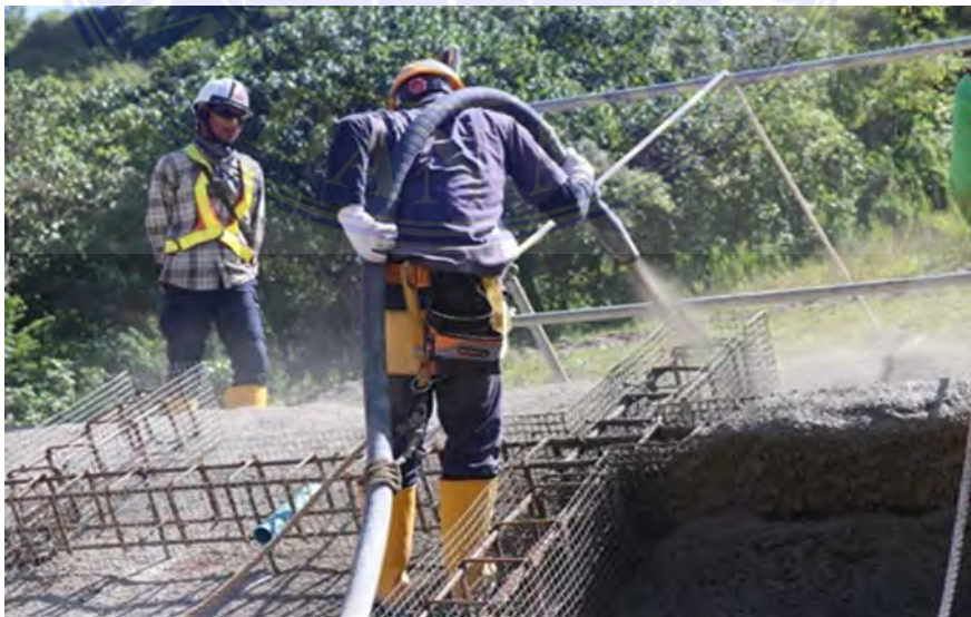
Gambar 4. 29 Pengecoran pada Free frame .
