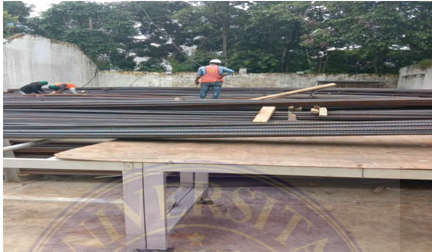
Gambar 4.3 Besi Tulangan Sumber : Dokumentasi
