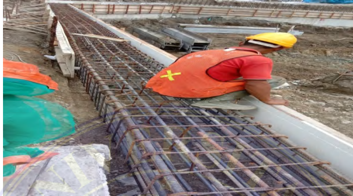
Gambar 3. 1 Pemasangan bekisting Sumber: Dokumentasi
