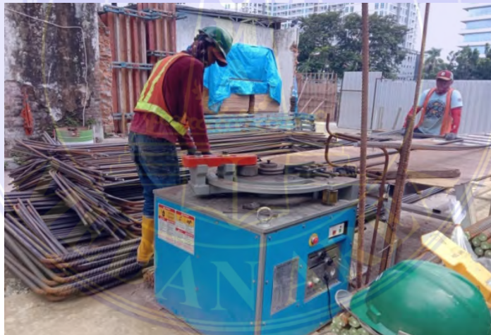
Gambar 3.4 Bar Bender Sumber : Dokumentasi
