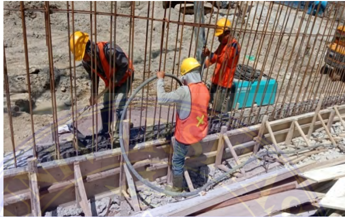
Gambar 4.6 Pengecoran pada Capping Beam Sumber : Dokumentasi
