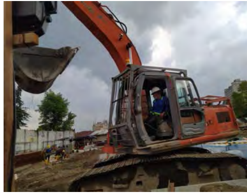
Gambar 3. 29 Excavator Sumber : Data Lapangan
