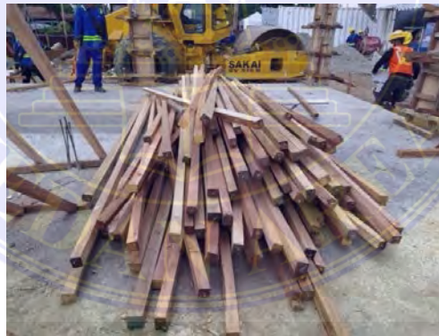
Gambar 3. 23 Kayu Sumber : Data Lapangan
