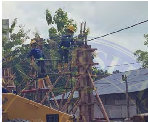
Gambar 4. 9 pelaksanaan pengecoran Sumber : Dokumentasi Lapangan
