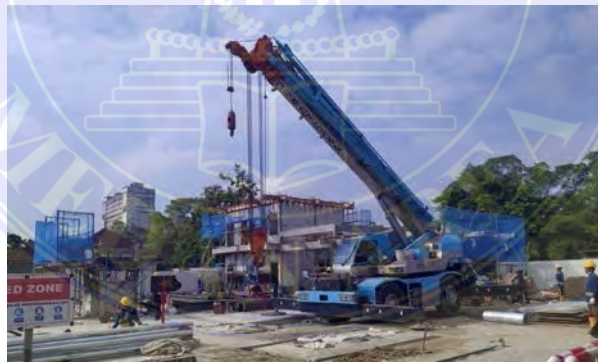
Gambar 3. 31 Truck Crane Sumber : Data Lapangan
