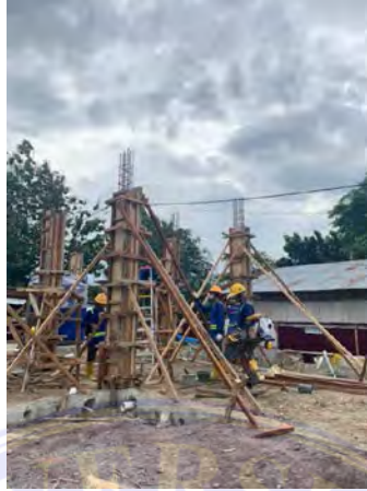
Gambar 4. 7 pemasangan bekisting kolom Sumber : Dokumentasi Lapangan
