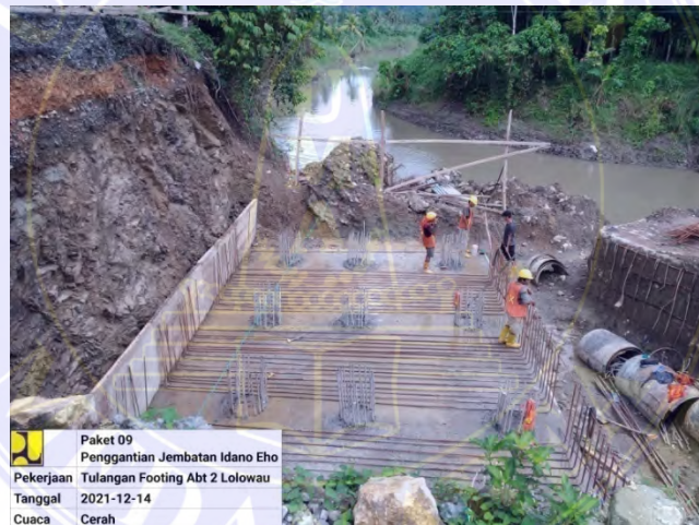
Gambar 4.9. Pembesian Footing
