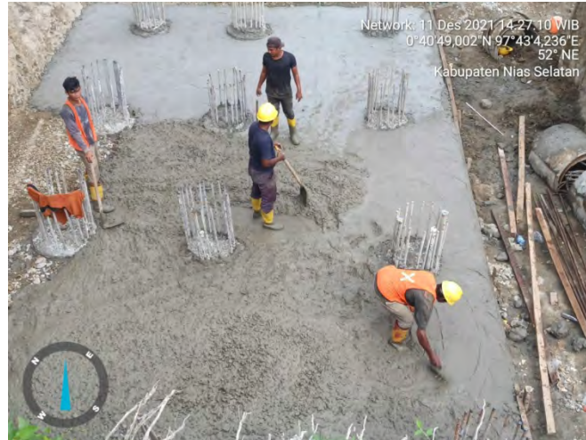
Gambar 4.8. Pengecoran Lantai Kerja
