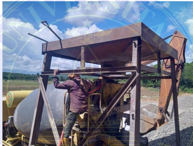
Gambar 8. Pembuatan Adonan Beton
