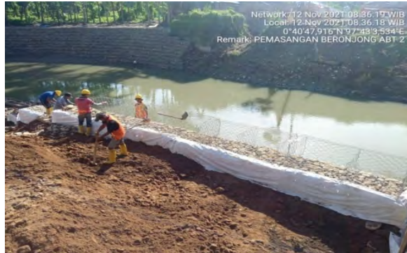
Gambar 4.22. Pemasangan Geotekstil
