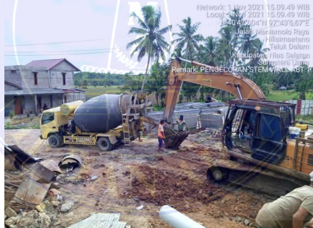
Gambar 4.11. Pengecoran Footing
