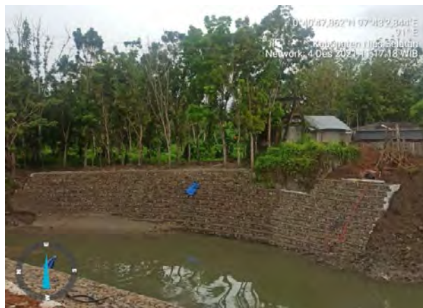
Gambar 4.20. Bronjong pelindung abutment arah Teluk Dalam
