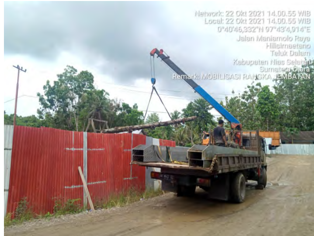
Gambar 7. Mobilisasi Rangka Baja
