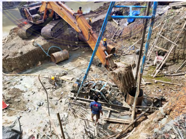
Gambar 4.2. Pemasangan Chasing bore pile
