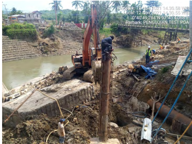
Gambar 4. Pemasangan Crane untuk Hammer PDA Test
