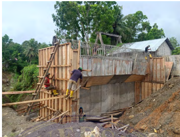
Gambar 4.12. Pelepasan Bekisting Footing
