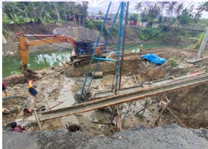
Gambar 3.6. Saluran Beton Cair
