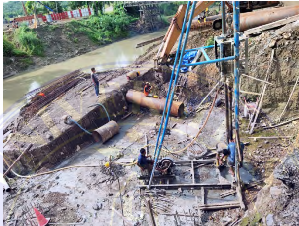
Gambar 4.1. Pengeboran bore pile
