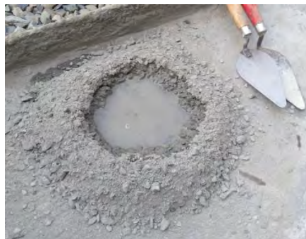
Gambar 3.9. Pencampuran agregat beton
