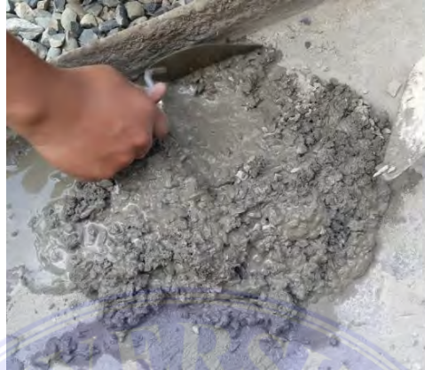
Gambar 3.10. Pengadukan campuran agregrat beton
