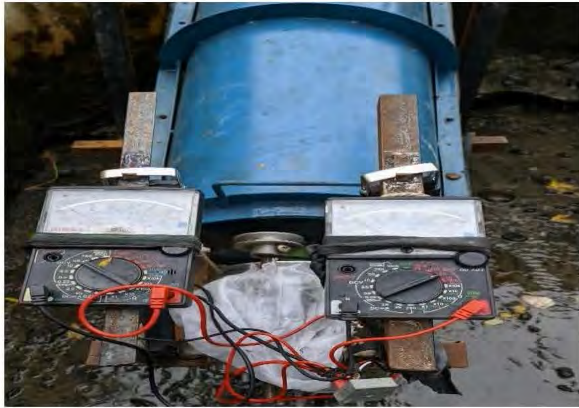
Gambar 3.11 Menghitung Tegangan dan Kuat Arus Pada Generator.
