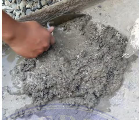
Gambar 3. 9. Pengadukan campuran agregrat beton
