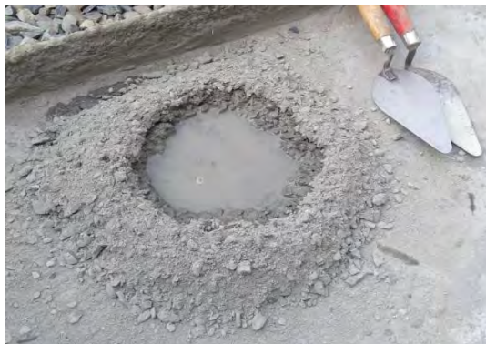
Gambar 3. 8. Pencampuran agregat beton
